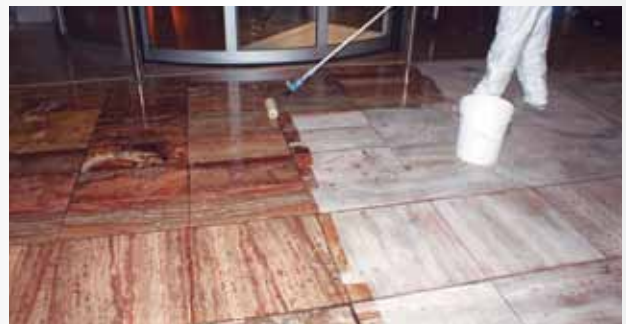
Application of the primer / fast curing RAYSTON K PRIMER
